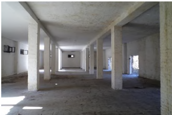
Gospodarska zgrada 14 – iznutra
