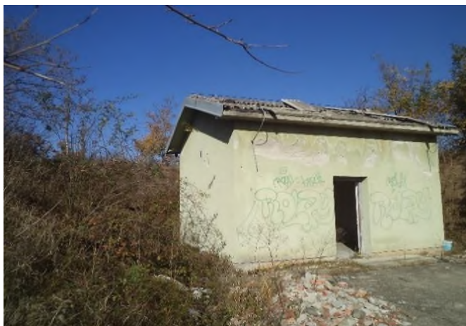
Gospodarska zgrada 26 – izvana (28 m 2 )
