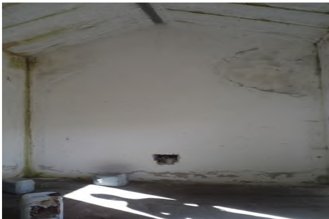
Gospodarska zgrada 26 – iznutra
