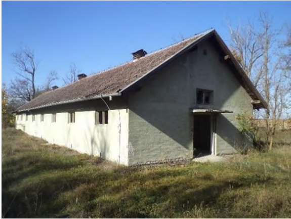
Gospodarska zgrada 3 – izvana (265 m 2 )
