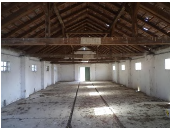
Gospodarska zgrada 1 – iznutra
