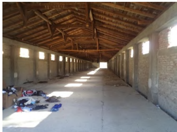
Gospodarska zgrada 4 – iznutra
