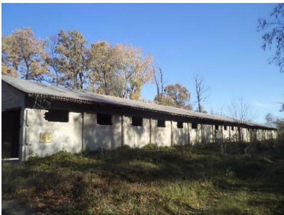
Gospodarska zgrada 4 – izvana (765 m 2 )
