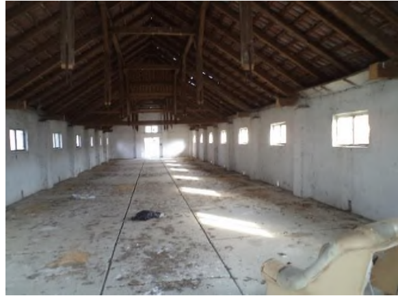
Gospodarska zgrada 3 – iznutra
