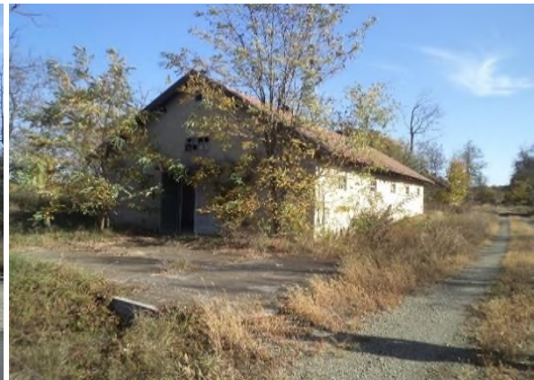
Gospodarska zgrada 1 – izvana (178 m 2 )
