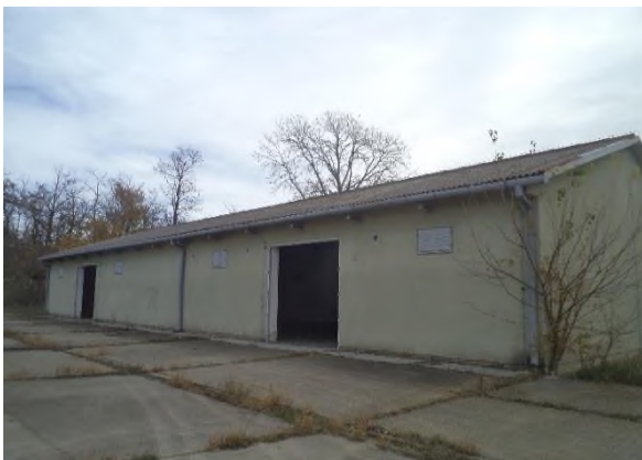
Gospodarska zgrada 9 – izvana (473 m 2 )
