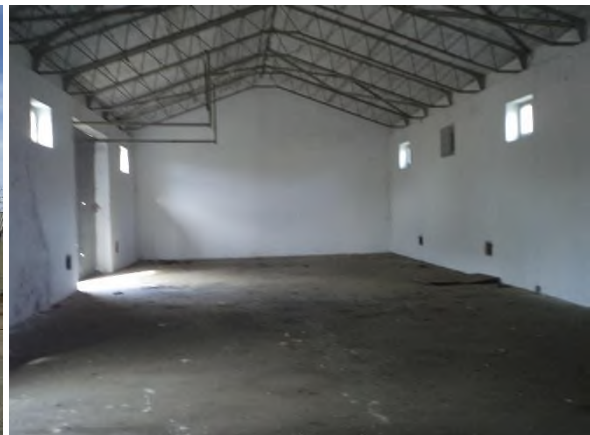
Gospodarska zgrada 6 – iznutra
