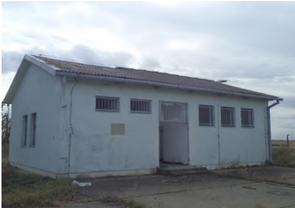
Gospodarska zgrada 8 – izvana (115 m 2 )
