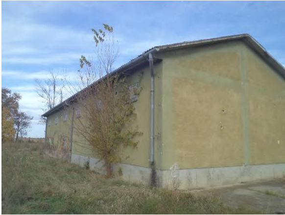
Gospodarska zgrada 7 – izvana (224 m 2 )
