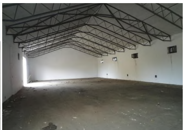
Gospodarska zgrada 9 – iznutra
