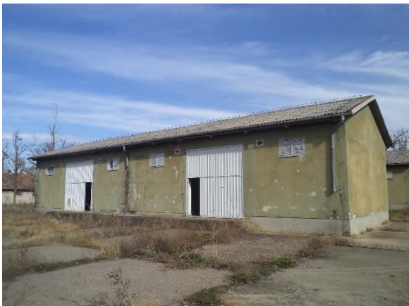
Gospodarska zgrada 6 – izvana (224 m 2 )
