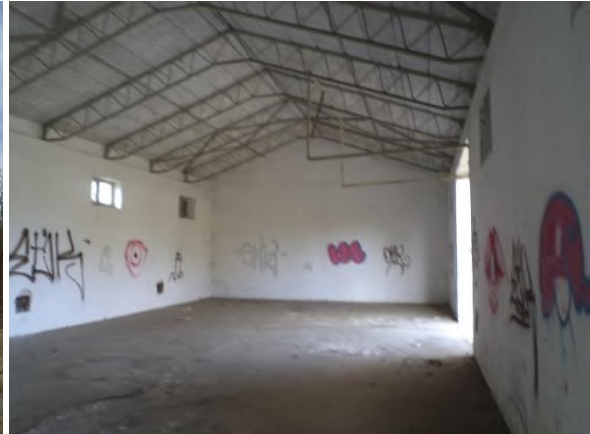
Gospodarska zgrada 5 – iznutra
