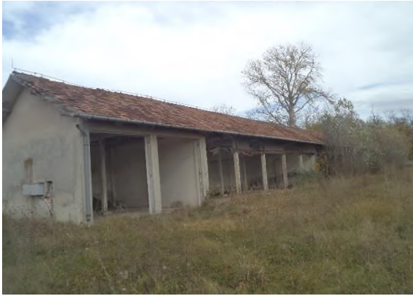
Gospodarska zgrada 10 – izvana (564 m 2 )
