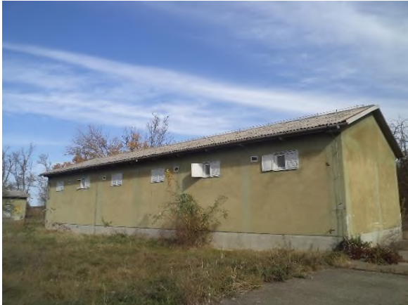
Gospodarska zgrada 5 – izvana (224 m 2 )
