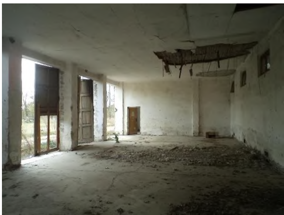
Gospodarska zgrada 11 – iznutra
