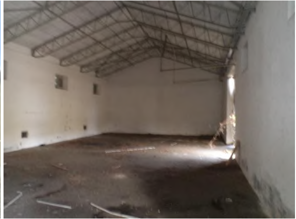
Gospodarska zgrada 7 – iznutra
