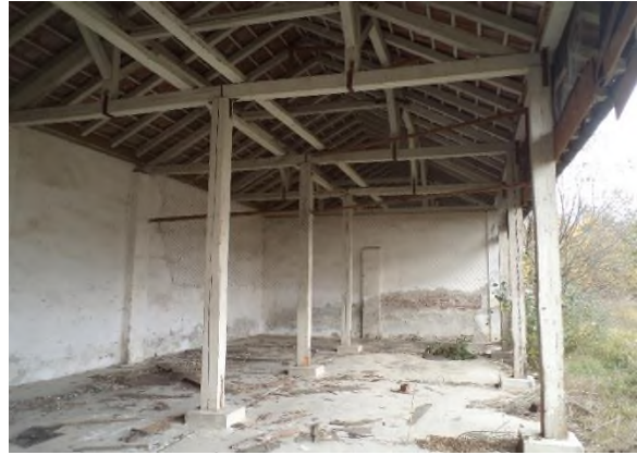
Gospodarska zgrada 10 – iznutra
