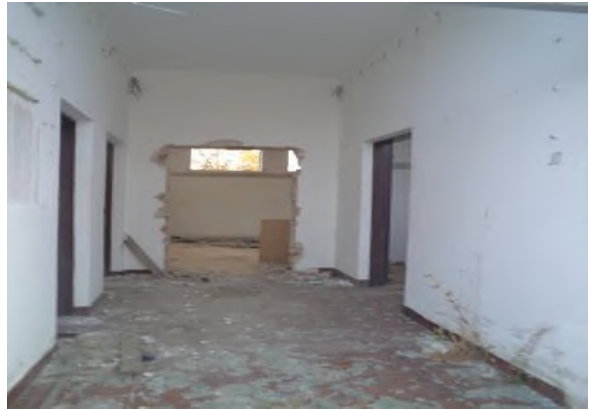
Gospodarska zgrada 8 – iznutra
