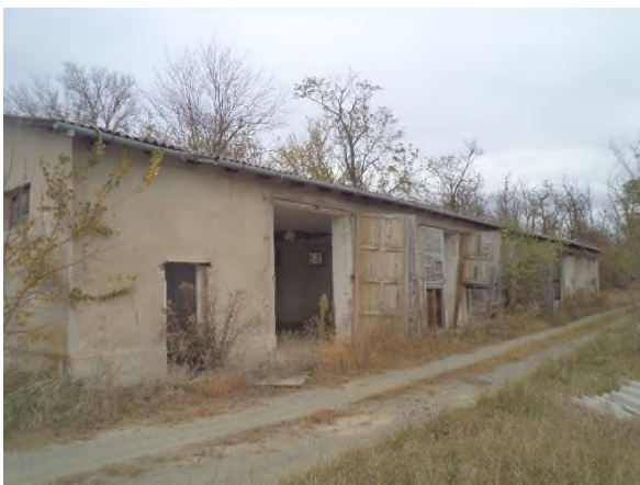
Gospodarska zgrada 11 – izvana (351 m 2 )
