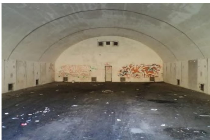
Gospodarska zgrada 12 – iznutra
