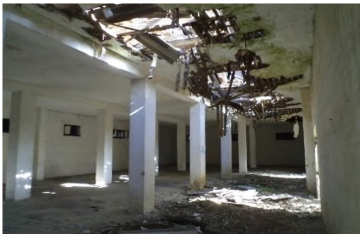
Gospodarska zgrada 13 – iznutra
