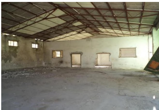
Gospodarska zgrada 16 – iznutra
