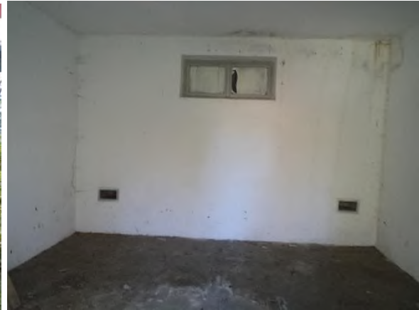
Gospodarska zgrada 22 – iznutra
