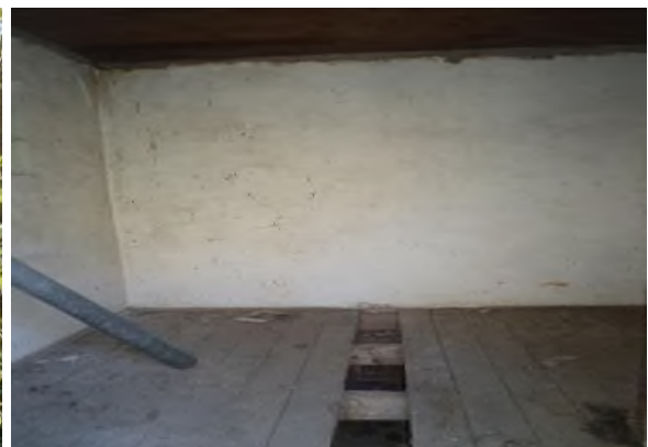
Gospodarska zgrada 23 – iznutra
