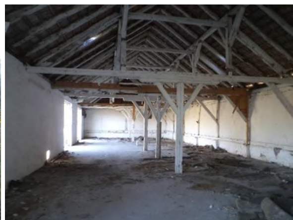
Gospodarska zgrada 19 – iznutra
