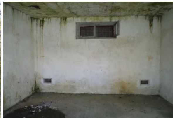
Gospodarska zgrada 21 – iznutra
