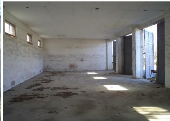
Gospodarska zgrada 20 – iznutra
