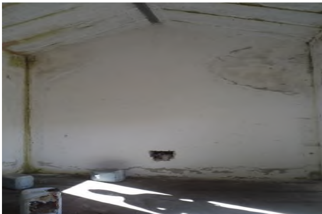
Gospodarska zgrada 26 – iznutra
