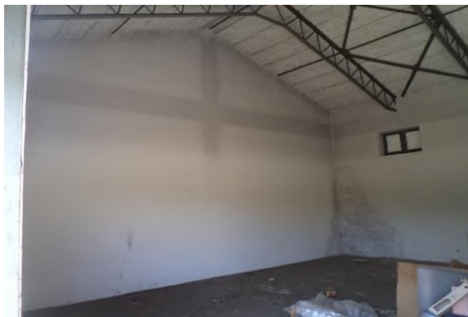
Gospodarska zgrada 27 – iznutra
