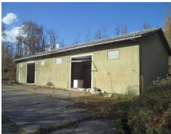
Gospodarska zgrada 28 – izvana (225 m 2 )
