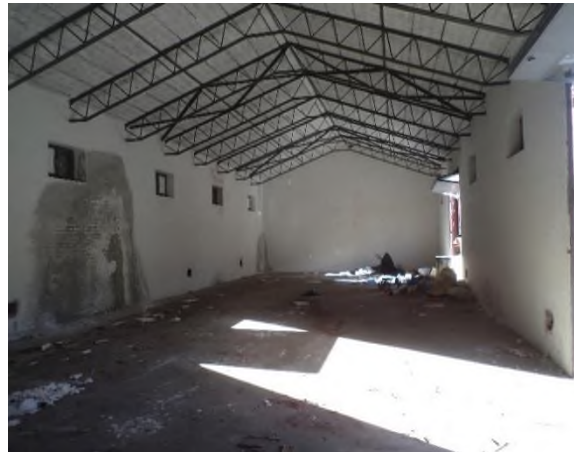
Gospodarska zgrada 28 - iznutra
